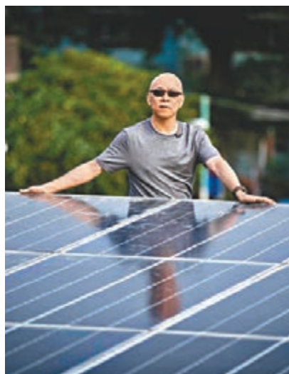
高先生在其西貢村屋的屋頂裝設了15塊太陽能板。中電供圖
