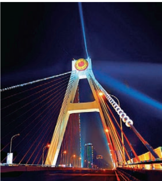
■成都天府立交橋
