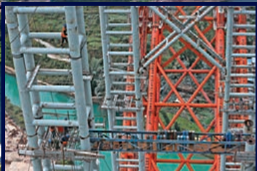
■工人師傅正在對吊裝到位的大橋豎立柱作焊接前的探測作業
