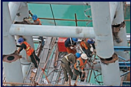
■工人師傅在高空對吊裝的豎立柱進行精準到位作業
