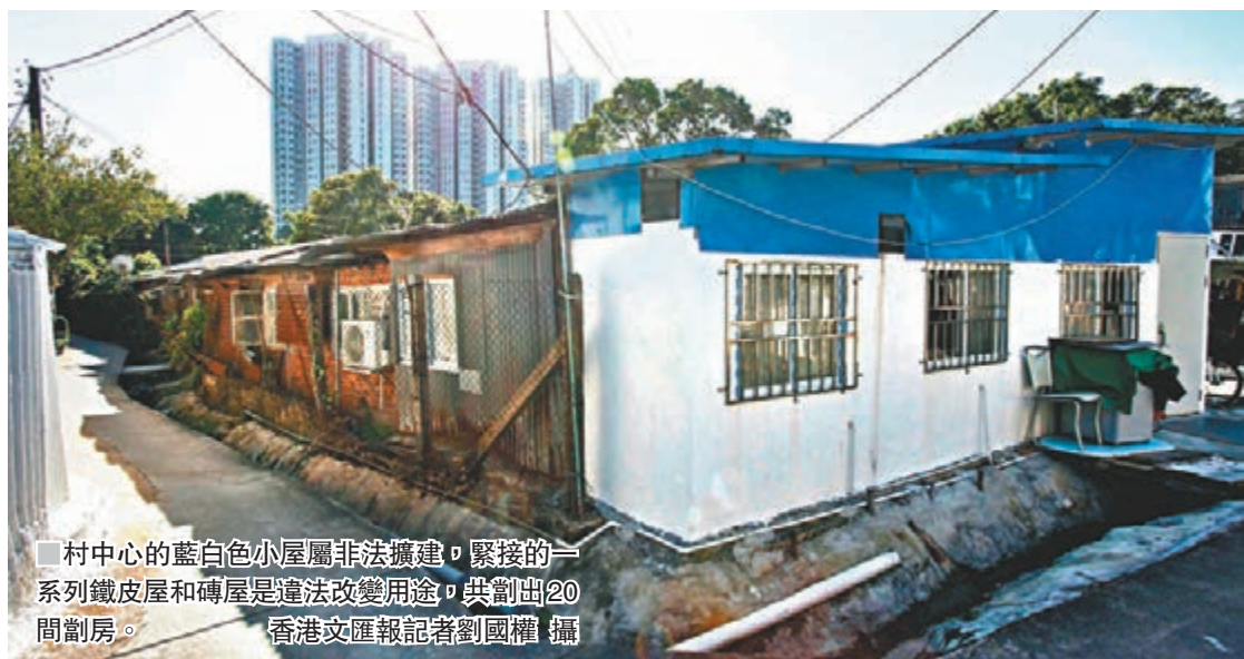
村中心的藍白色小屋屬非法擴建，緊接的一系列鐵皮屋和磚屋是違法改變用途，共劃出20間劏房。
