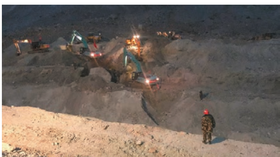
金沙江堰塞湖今日過流。圖為11月10日工程人員在該壩壩體連夜實施過流槽開挖作業。新華社
