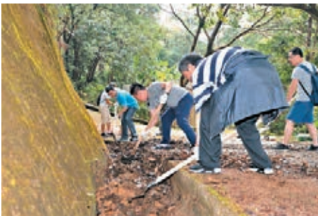
「山竹」過後，中聯辦義工清理郊園排水溝渠。
