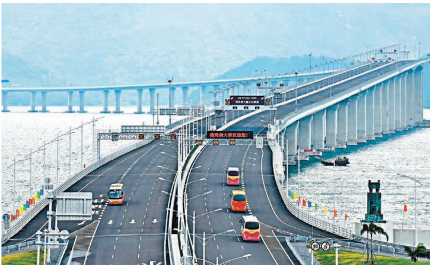
港珠澳大橋上周已正式通車。
