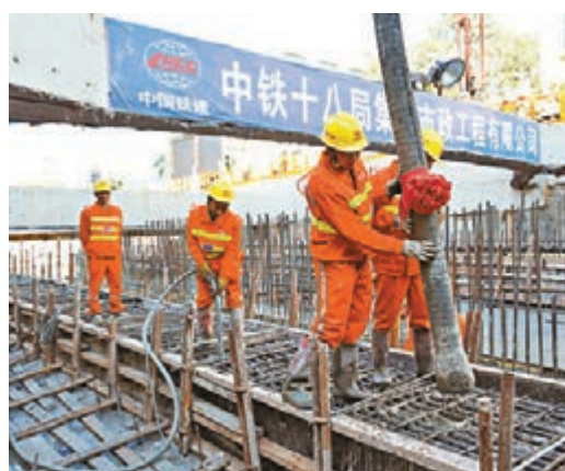
地鐵施工人員正在為最後一塊頂板澆築。
