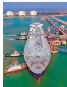
LNG接收站，並完成卸載，這意味着中國進口LNG窗口一站通首期試點產品進入了船貨交割階段，標誌着我國LNG接收站首次實現以公開競價市場化運作的方式實現向第三方公開開放。
