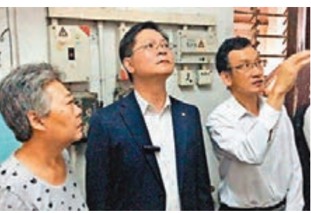
在劉太陪同下，薛永恒和何志偉到大廈頂層視察升降機機房設備。
