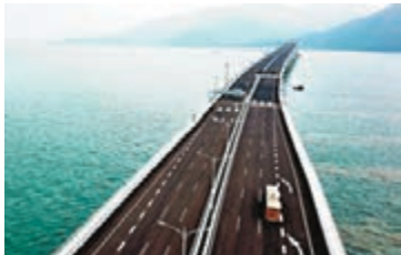
■港珠澳大橋已正式通車。新華社
