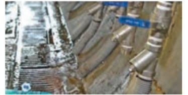
■ 土力工程處會定期檢查寶珊道的排水隧道,用水閘控制地下水位。 視頻截圖
