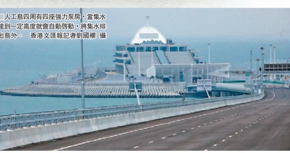
人工島四座強力泵房，當集水達到一定高度就會自動啟動，將集水排出島外。
