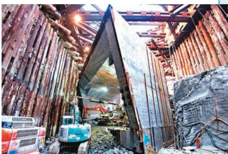
於機場快線下就觀景山隧道進行的箱涵頂進隧道工程。
