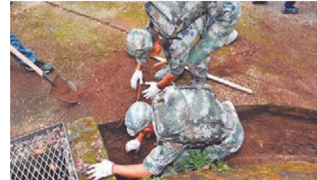
駐港部隊官兵用手疏通排水渠堵塞。中聯辦網站圖片
