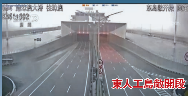
隧道行車管廊
