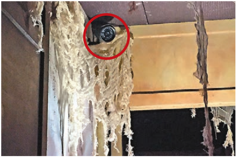
場內角落有不少閉路電視及逃生照明裝置（紅圈示）。
