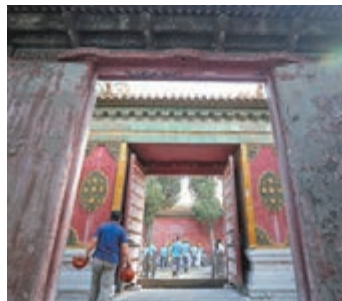
故宮養心殿研究性保護項目古建築維修保護昨日正式開工。圖為養心門。 中新社
