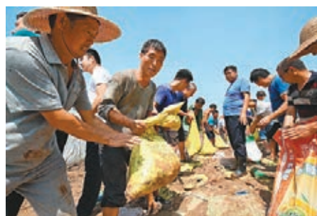
■山東壽光群眾裝填沙袋加固堤壩。
