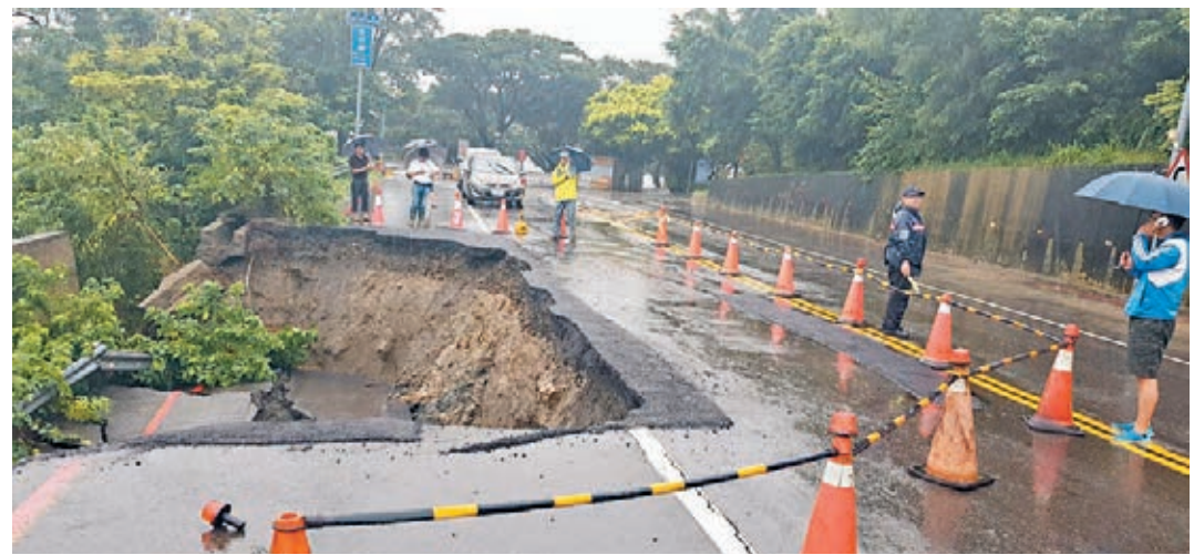
高雄萬壽山橋前道路因暴雨發生嚴重塌陷，場面觸目驚心。
