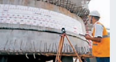
中鐵上海工程局集團的工作人員在轉體施工現場測量轉體角度。新華社
