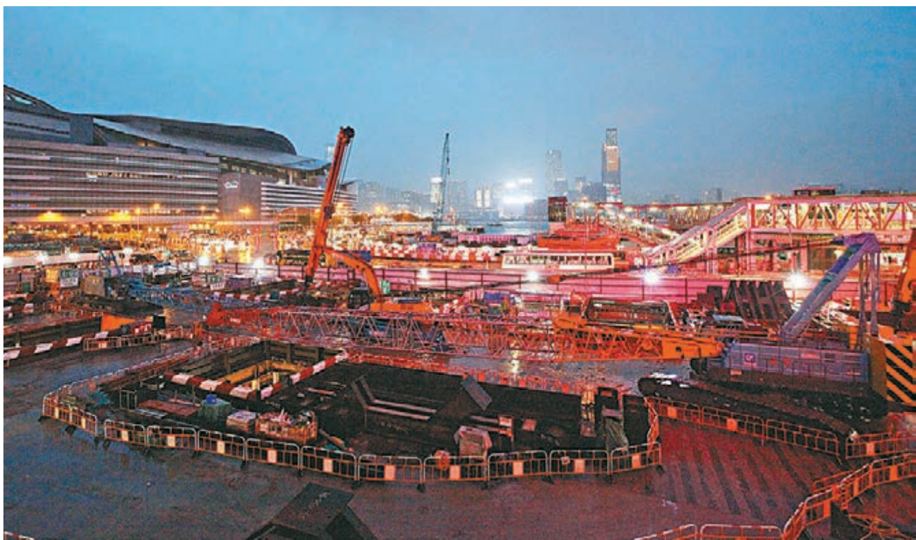
港鐵昨日傍晚宣佈，暫停會展站所有相關挖掘工程。
