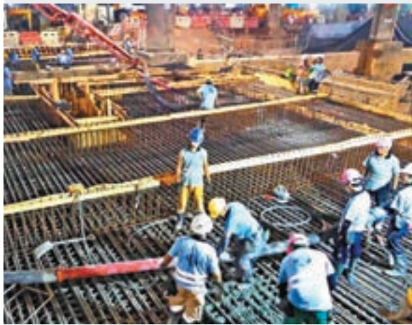
沙中線紅磡站施工情況。
