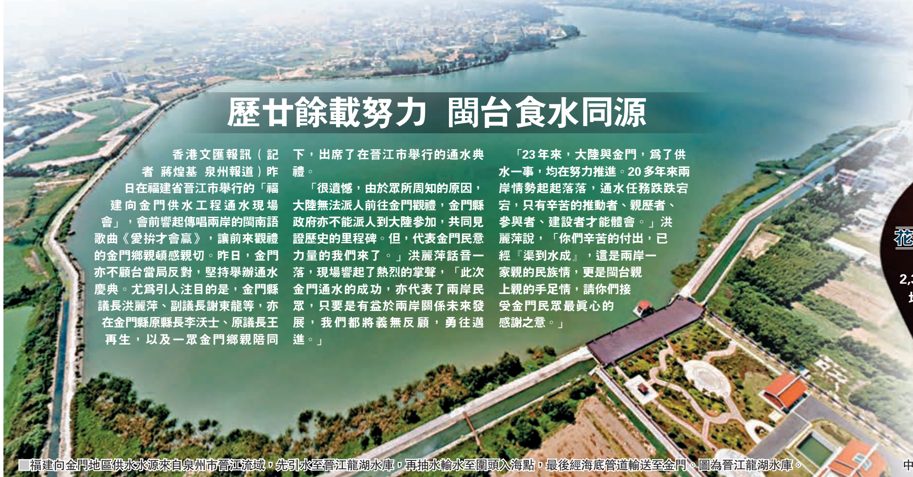
福建向金門地區供水水源來自泉州市晉江流域，先引水至晉江龍湖水庫，再抽水輸水至圍頭入海點，最後經海底管道輸送至金門。圖為晉江龍湖水庫。
