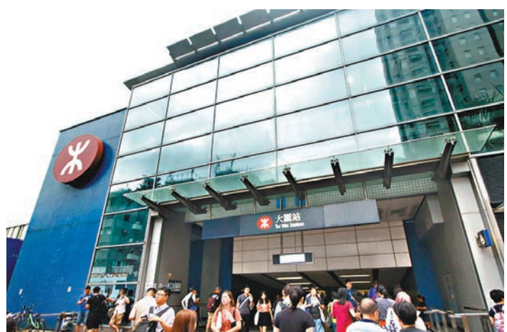
港鐵東鐵線大圍站的沉降幅度出現擴大跡象。資料圖片
