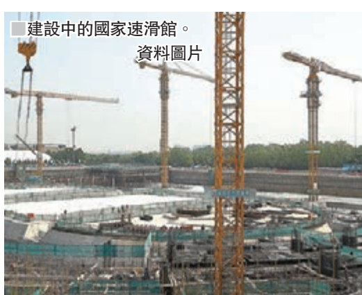
建設中的國家速滑館。
