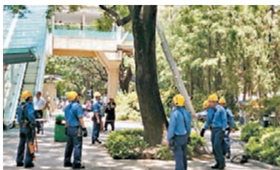
■發生塌樹傷人意外後,消防員到場爬長梯將大樹有危險樹丫清理。
