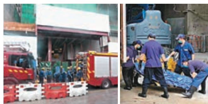
■商廈地盤昨日發生工人墮電梯槽 墮電梯槽工人遺體由伴奪命工業意外。
