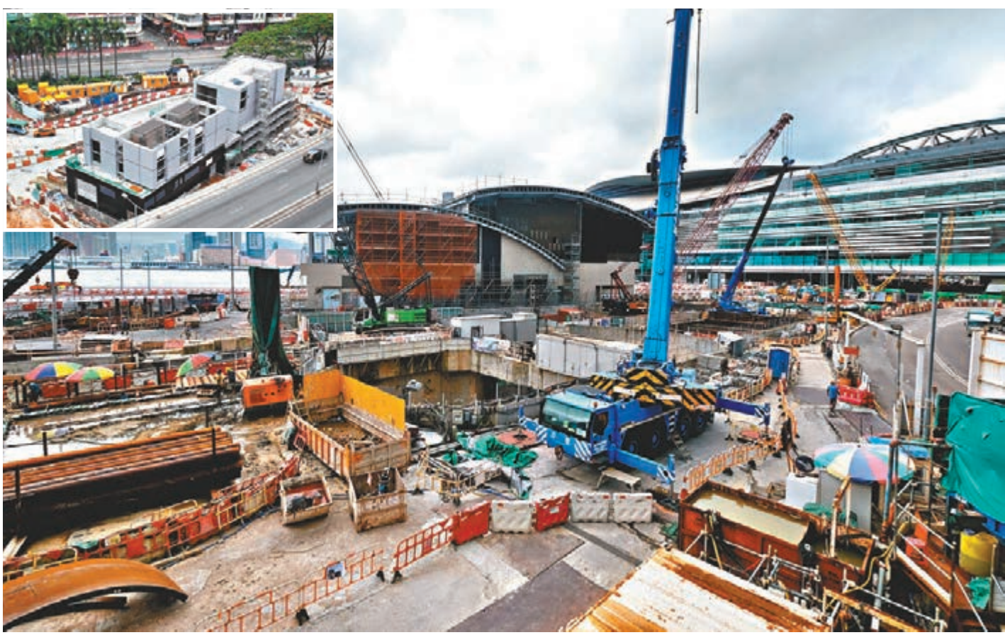
政府指出，若港鐵在沙中線工程中有缺失必定追究。小圖為沙中線土瓜灣站，大圖為沙中線會展站地盤。資料圖片
