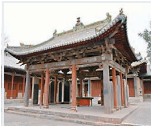
■山西晉城陽城縣「下交湯地廟」修繕後的面貌。 網上圖片
