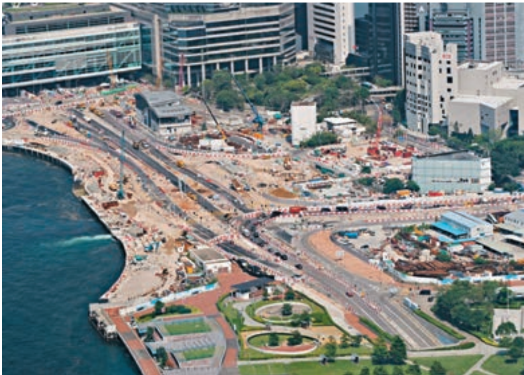
■金鐘和會展之間新建道路工地及港鐵沙中線會展站工地。
