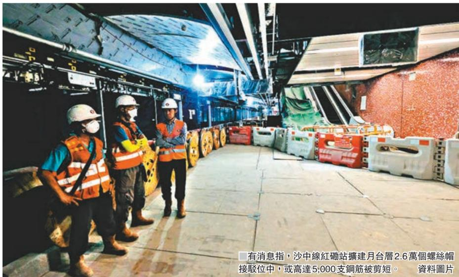
有消息指，沙中線紅磡站擴建月台層2.6萬個螺絲帽接駁位中，或高達5,000支鋼筋被剪短。資料圖片
