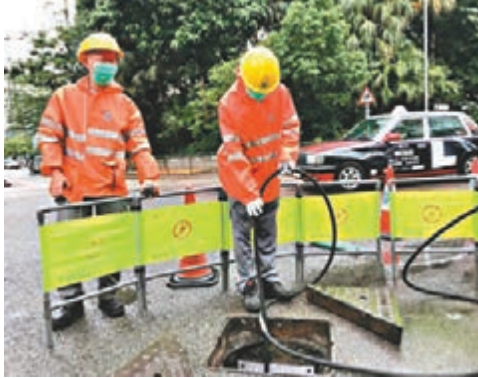
■古偉明（左）表示，渠務署人員會運用鏟枝或高壓水車上的水槍打通淤塞渠管。
