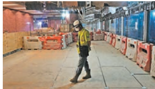
沙中線紅磡站擴建地盤的工程質量引起議員關注。資料圖片
