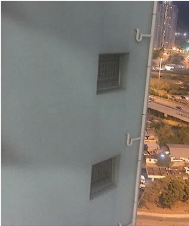
■從大廈走廊望出，可見其中有兩層樓的後樓梯黑漆漆。
