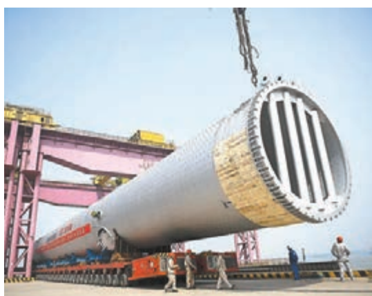
昨日，在江蘇鎮江一處碼頭前，世界上最重的加氫反應器被吊起運裝運輸船上。
