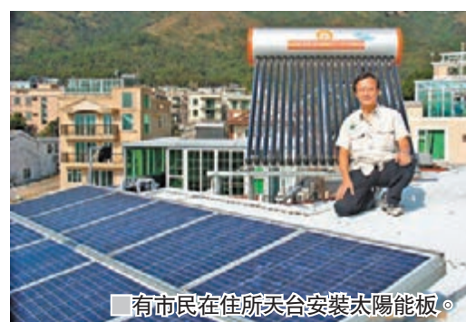
有市民在住所天台安裝太陽能板。
