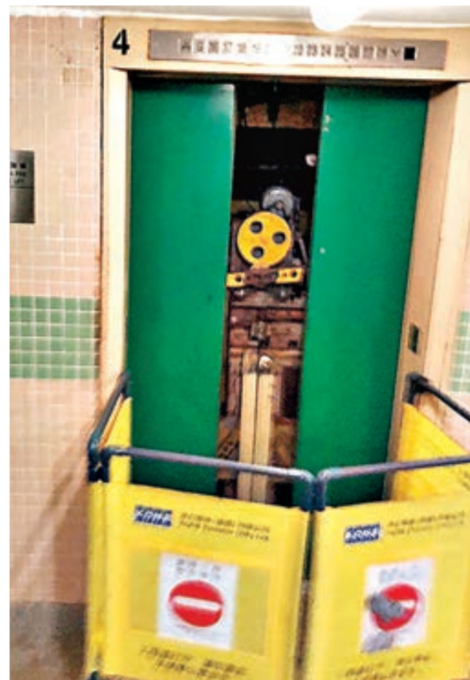
位於28樓的升降機出入口被圍封檢查。
