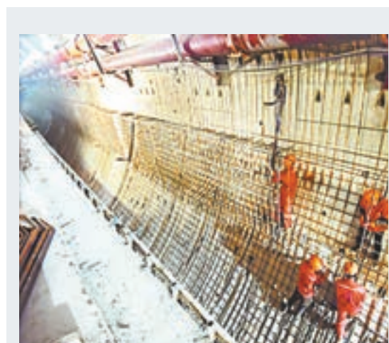
逾500施工人員春節在隧道內綁紮鋼筋，日夜趕工。網上圖片
