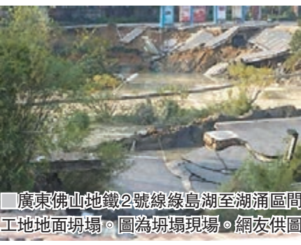
廣東佛山地鐵2號線綠島湖至湖涌區間工地地面坍塌。圖為坍塌現場。網友供圖
