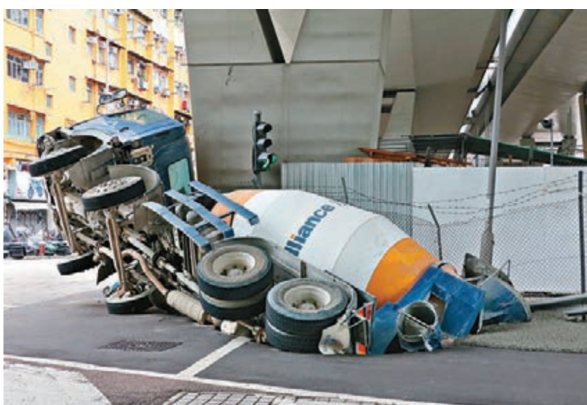
田螺車下半身墜入路坑。
