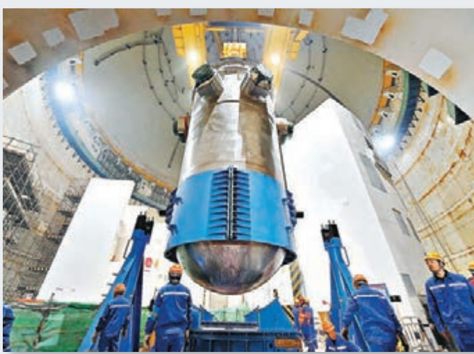
28日，「華龍一號」全球首堆、中核集團福清核電5號機組反應堆壓力容器順利吊裝入堆。該設備是我國首個具有完全自主知識產權的三代核電工程壓力容器。新華社
