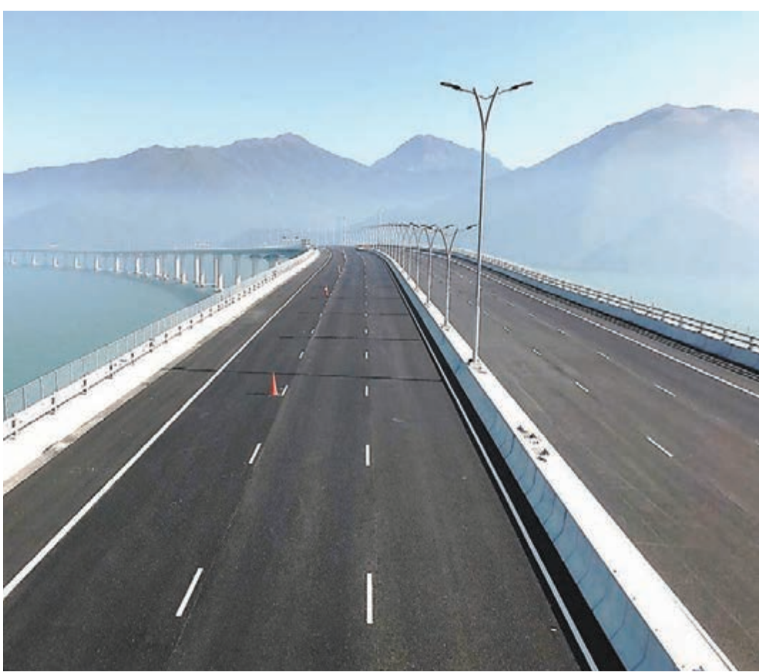
■ 港珠澳大橋香港接線路面鋪裝及道路設施已順利完工,高架橋段的負重荷載測試亦已經完成。圖為港珠澳大橋位於西部水域的一段香港接線高架橋。
