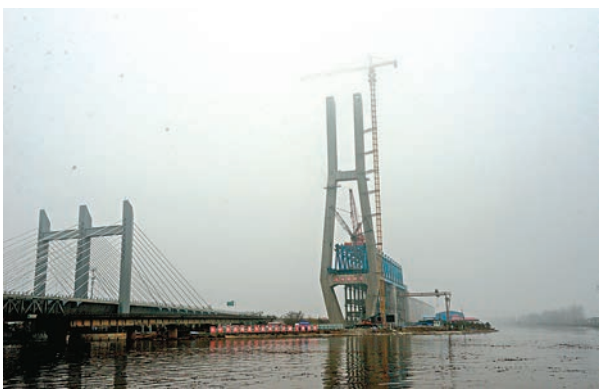
鹽通鐵路經過的新洋港斜拉橋施工現場。香港文匯報記者賀鵬飛攝
