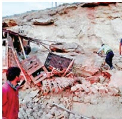
■以磚塊搭建的房屋倒塌。網上圖片
