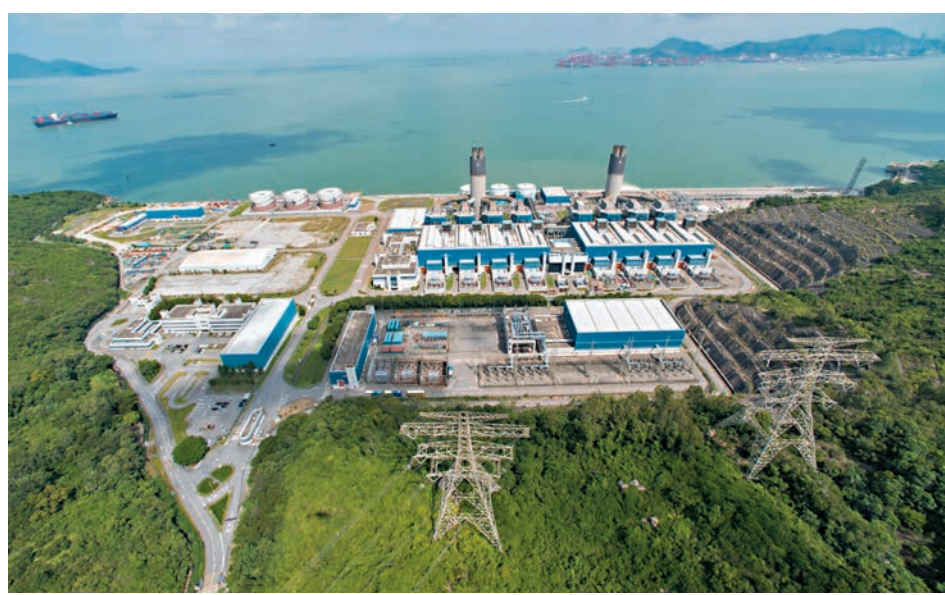
■圖為位於龍鼓灘的中電發電廠。來源：中電網頁
