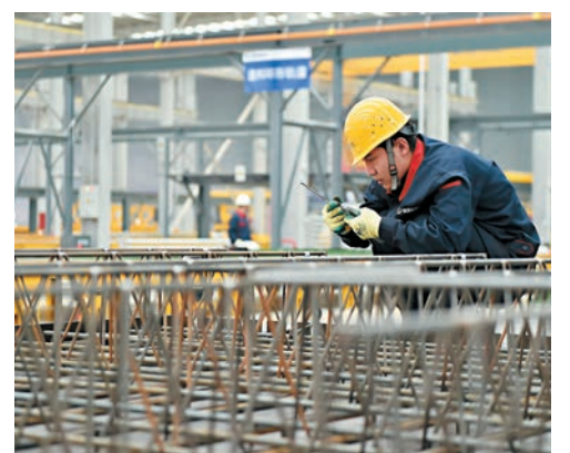
■圖為內地一個装配式建築產業基地內，工人在調試捆綁鋼筋的工具。資料圖片
