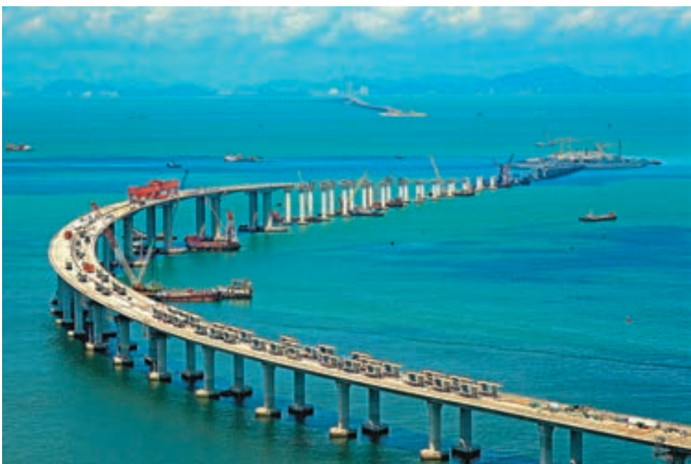
■ 跨境基建的接連落成，讓香港迎來融入內地發展的大好機遇。圖為建設中的港珠澳大橋。
