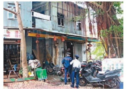
消防到發生火警的鐵皮屋維修場調查。
