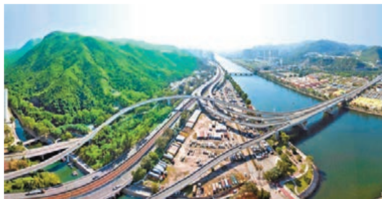
■沙田污水處理廠正準備遷往城門河彼岸女婆山的擬建岩洞內。
