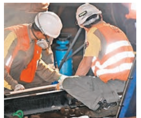
工程人員在港鐵火炭站更換有裂紋的路軌。
