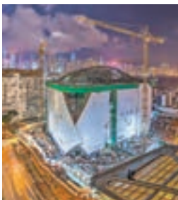
■建設中的西九戲曲中心。 西九文化區管理局提供
